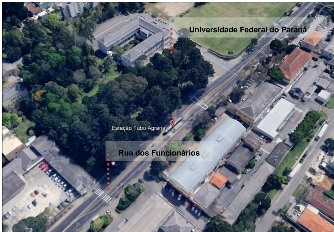
Figura 2: Implantação Estação Protótipo Agrárias - infraestrutura existente
