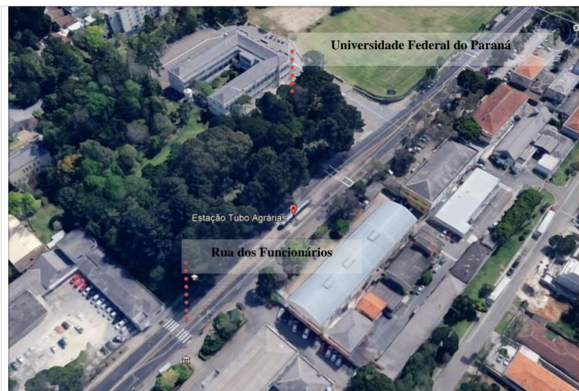
Figura 2- Implantação Estação Protótipo Agrárias - infraestrutura existente
