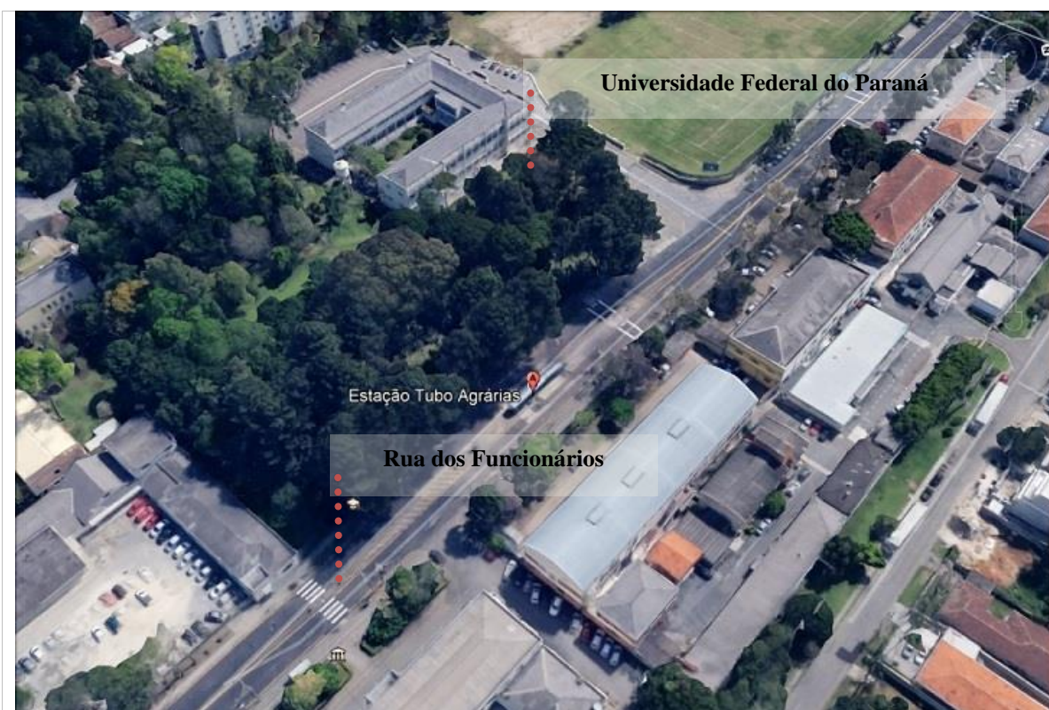
Figura 2- Implantação Estação Protótipo Agrárias - infraestrutura existente
